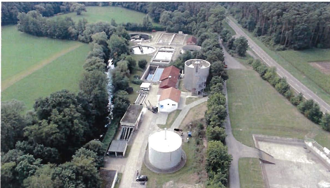
Ansicht auf die Kläranlage aus Osten
